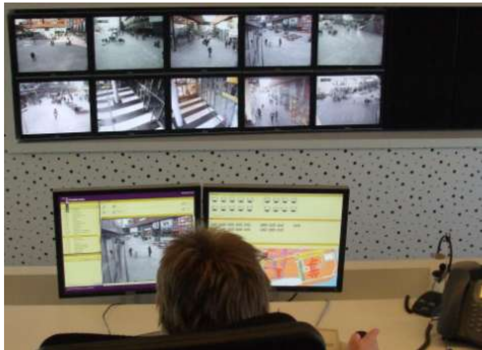
Afbeelding 2.1 Werkplek van een observant – twee monitoren op tafel en tien aan de wand. Er zijn twee van dit soort werkplekken in de centrale.
