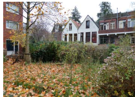
Achterterrein en achterzijde Grachtstraat
