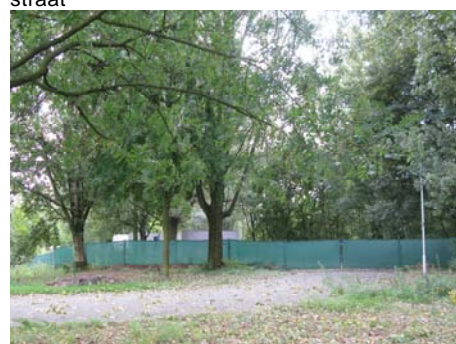
Afscherming woonunits; zicht vanaf parkeerterrein Olympusplein
