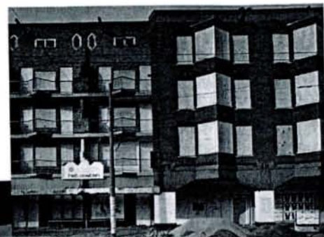
Westseite Mercatorplein vor der Sanierung
