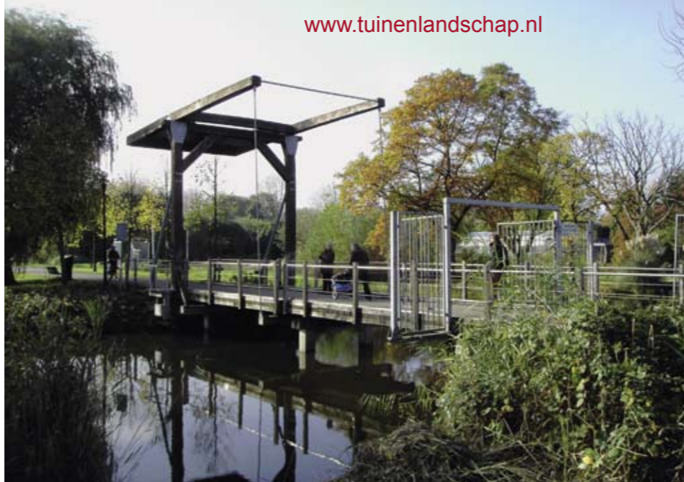
In het Amsterdamse park Frankendael kan de toegang tot de schooltuinen worden afgesloten om te voorkomen dat er gestolen wordt.
