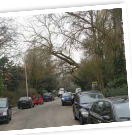
▲ Zichtbaarheid negatief: bochtige weg met overhangende boom (in combi met onvoldoende verlichtingsarmaturen belemmert de zichtbaarheid.
