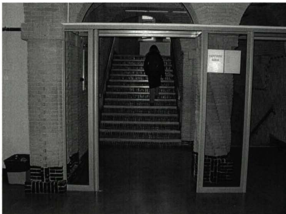
Perfekte brandcompartimentering in een historisch gebouw.
