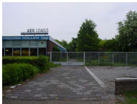
Locatie van de nieuwe entree aan de westkant, gezien vanaf de Lammenschansweg
