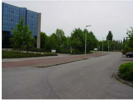
Entree van Kanaalpark, links van de weg komt de opstelruimte
